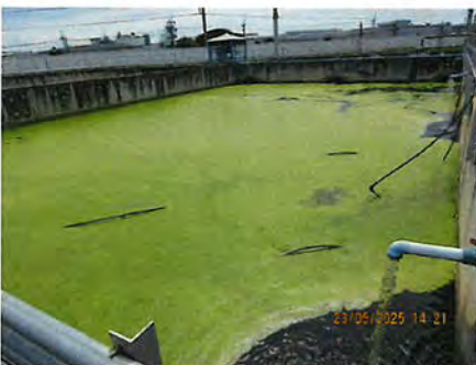
ภาพที่ 2-15 บ่อกักน้ำหล่อเย็น
