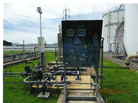
ภาพที่ 2-14 ระบบ Online Monitoring บริเวณบ่อกักน้ำทิ้งรวม
