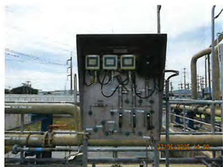
ภาพที่ 2-16 ระบบ Online Monitoring บริเวณบ่อกักน้ำหล่อเย็น
