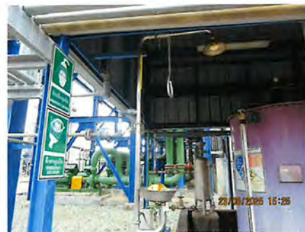
ภาพที่ 2-55 ฝักบัวชำระล้างร่างกายและที่ล้างตา (Safety Shower&Eye Washer)
